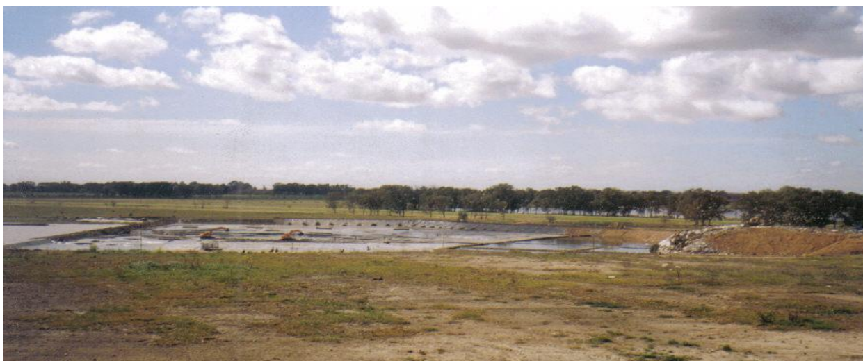
Relleno Sanitario de Ensenada Fotografía tomada por el autor en agosto de 2005 Operación del relleno sanitario.
