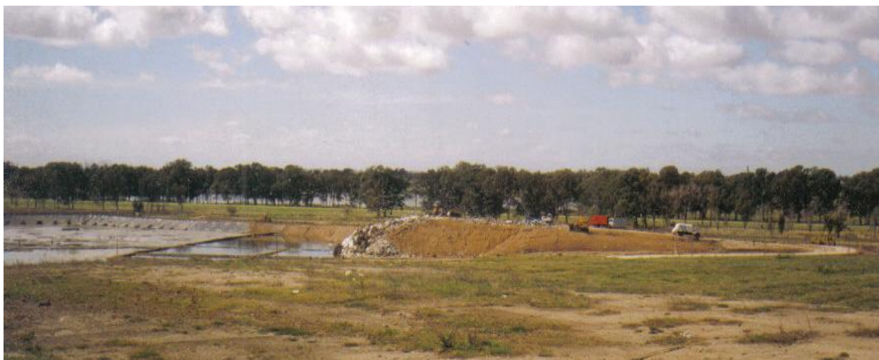
Relleno Sanitario de Ensenada Fotografía tomada por el autor en agosto de 2005. Terraplén de descarga en un módulo. Descarga de residuos en forma conjunta.
