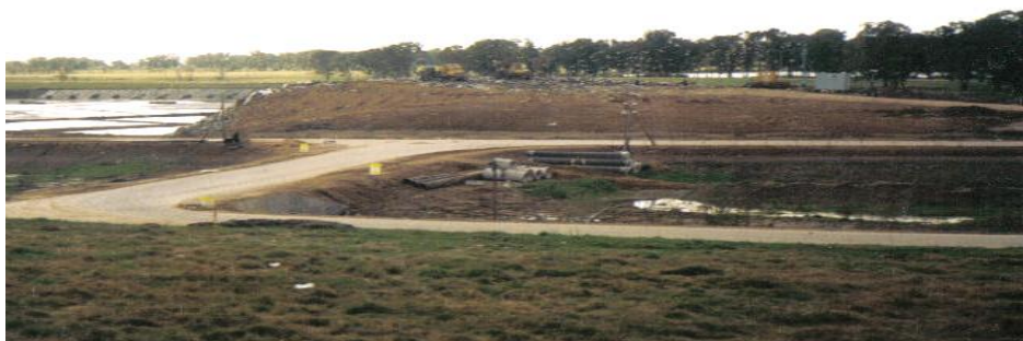
Relleno Sanitario de Ensenada Fotografía tomada por el autor en agosto de 2005 En el centro de la fotografía: rollos de polietileno de alta densidad utilizados para impermeabilizar la base del relleno sanitario.
